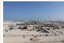
WORLD'S LARGEST LNG PROJECT NFE (2021)
