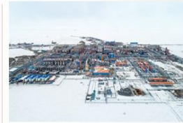
WORLD'S LARGEST MODULARIZED LNG PROJECT Yamal LNG (2014)
